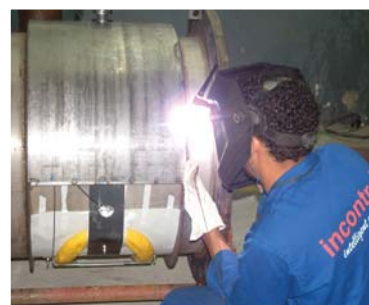
VMF na solda
