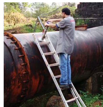
VMI em tubulação de 2 metros de diâmetro em usina hidrelétrica
