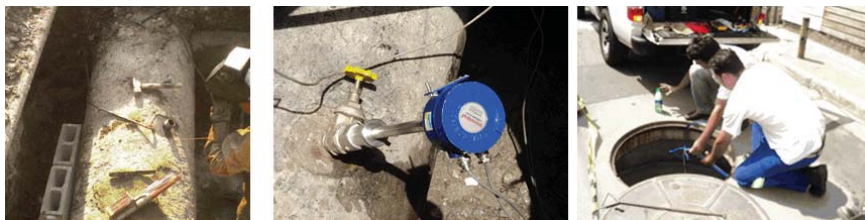
Etapas 2 - Instalação dos Macromedidores (MSEG/UGR SANTO AMARO/MSEL E INCONTROL)
