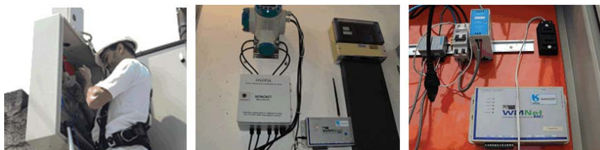
Etapas 2 - Instalação dos Macromedidores (MSEG/UGR SANTO AMARO/MSEL E INCONTROL)
