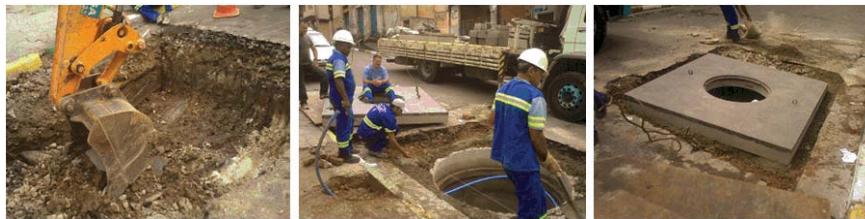
Etapas 1 - Construção das caixas p/ instalação do Macromedidor (UGR Santo Amaro)
