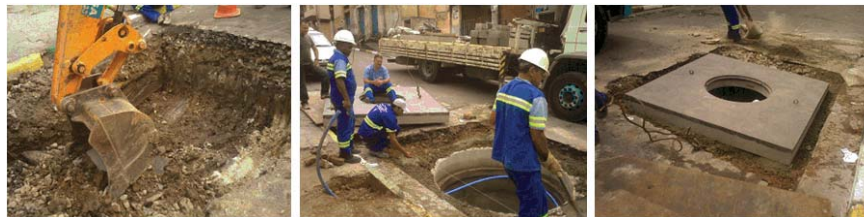
Etapas 1 - Construção das caixas p/ instalação do Macromedidor (UGR Santo Amaro)
